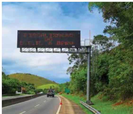
As Colunas são fabricadas em perfis conformados em chapas planas, dobradas a frio, formando a seção “C”.
